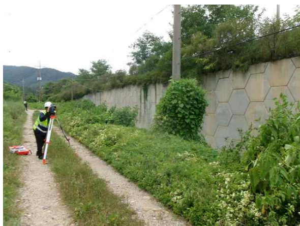
광파기를 이용한 측량 작업
